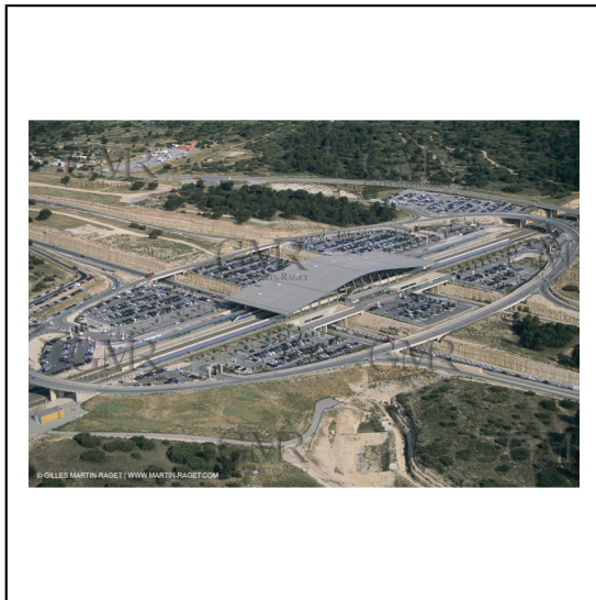
France, Provence, Pays d'Aix en Provence, Gare TGV
