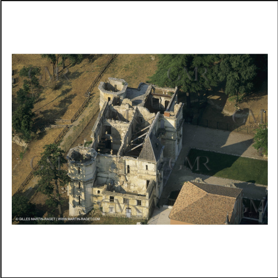
France, Provence, Pays d'Aubagne, collines de Marcel Pagnol, Chateau de la BUSINE
