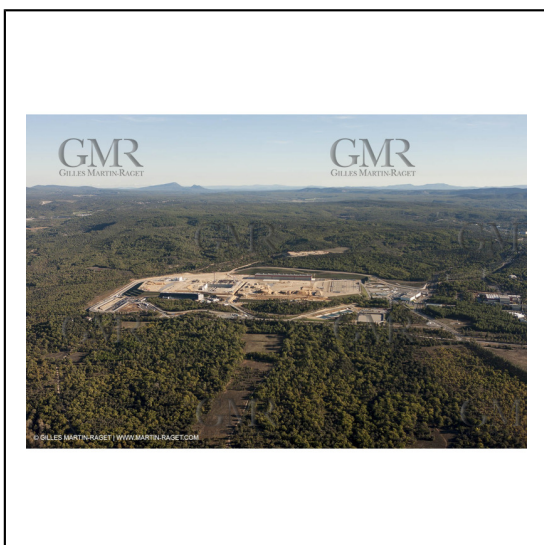
29/10/2012 - Val de Durance (FRA, 84) - Chantier ITER***29/10/2012 - Val de Durance (FRA, 84) - ITER project under work
