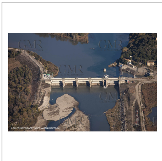
29/10/2012 - Val de Durance (FRA, 84) - Barrage de Cadarache***29/10/2012 - Val de Durance (FRA, 84) - Cadarache barrage
