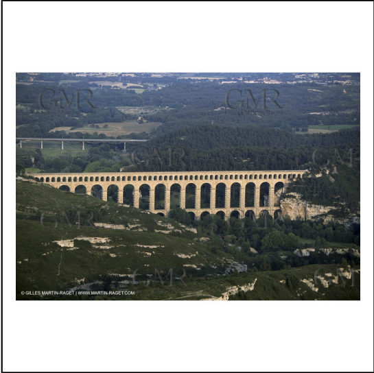
Pays d'Aix en Provence - Acqueduc de Roquefavour***Aix en Provence area - Roquefavour bridge
