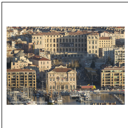
06/12/2012 - Marseille (FRA,13) Hôtel de ville et Hôtel Dieu en réfection***06/12/2012 - Marseille (FRA,13) - City Hall and Hotel Dieu Hotel under works
