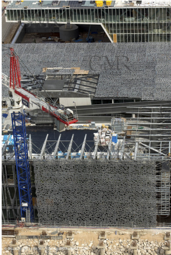
28/09/2012 - Marseille (FRA,13) - Travaux sur le Vieux Port, Construction du MUCEM, Renovation du Fort Saint Jean, construction du Centre Régional de la Meriterranée, CEREM,
