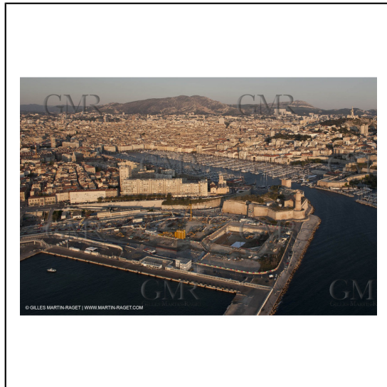
22/06/2010 - Marseille (FRA,13) Chantier du Mucem***22/06/2010 - Marseille (FRA,13) Chantier du Mucem
