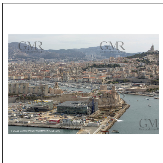
28/09/2012 - Marseille (FRA,13) - Travaux sur le Vieux Port, Construction du MUCEM, Renovation du Fort Saint Jean, construction du Centre Régional de la Meriterranée, CEREM,
