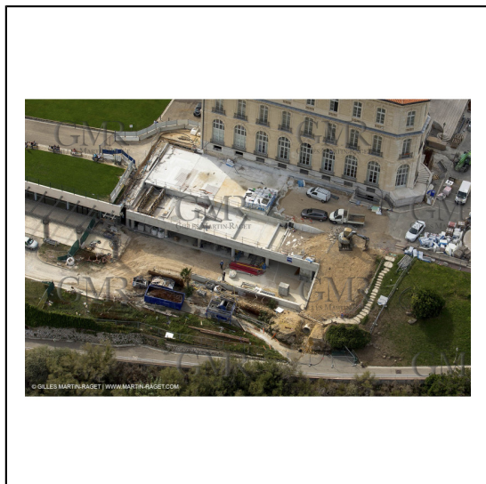
28/09/2012 - Marseille (FRA,13) - Travaux sur le Vieux Port, Construction du MUCEM, Renovation du Fort Saint Jean, construction du Centre Régional de la Meriterrannée, CEREM,
