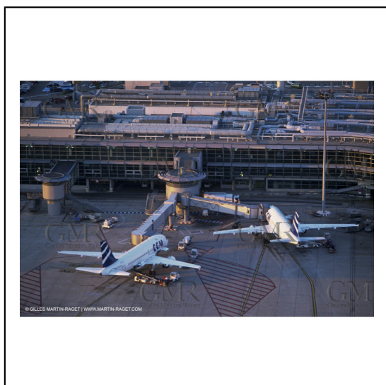
Aéroport de Marseille Provence (Fra,13)***Aéroport de Marseille Provence (Fra,13)
