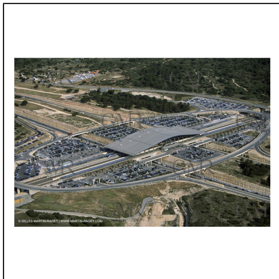
Agre TGV Aix en Provence***TGV Speed train - Aix en Provence Station
