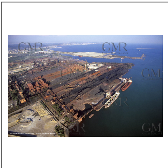
Golfe de Fos, terminal minéralier***Fos harbour, mineral terminal
