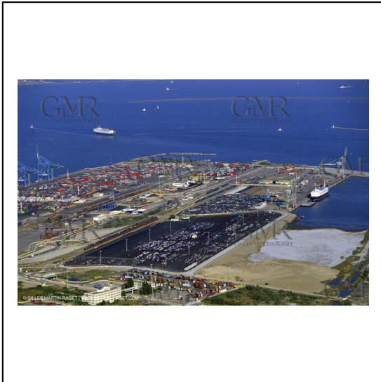
Terminal Containers de Fos sur mer*** Fos Container terminal
