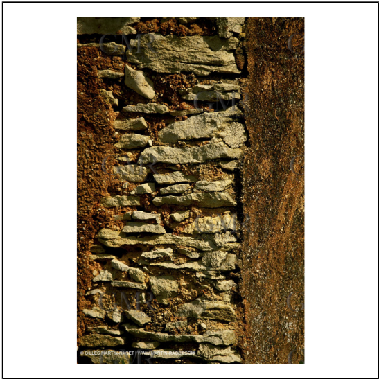
Luberon - Détail cabanon***Luberon - Cant detail
