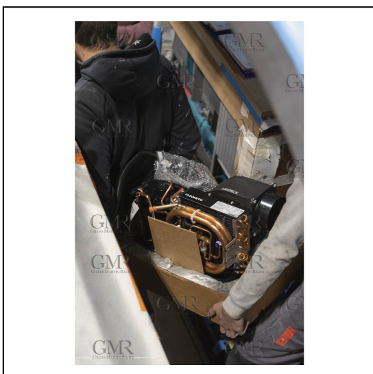
29/10/2018, La Grande Motte (FRA,30), Chantier Gunboat, construction du Gunboat 68, montage système air conditionné
