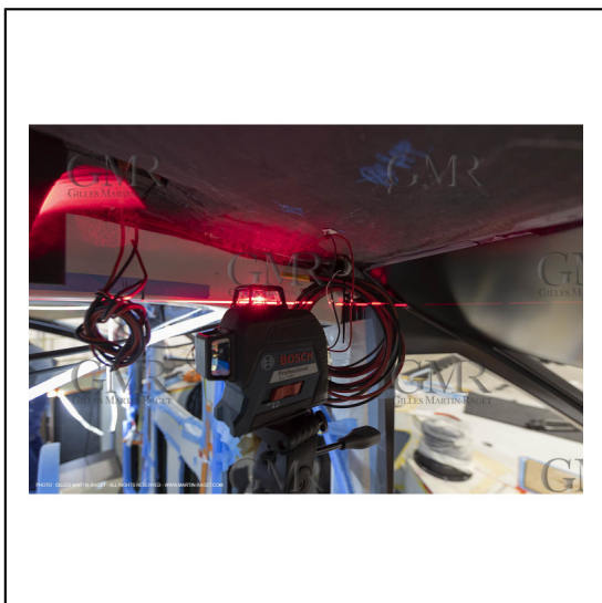
29/10/2018, La Grande Motte (FRA,30), Chantier Gunboat, construction du Gunboat 68, vérification laser pour pose vaigrage plafond
