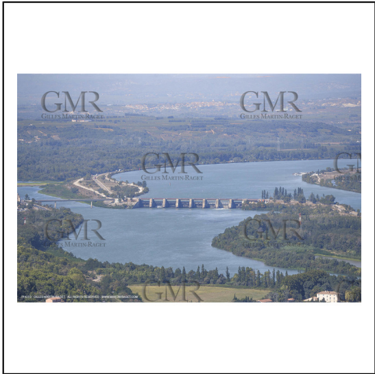
arrage de Vallabrègues
