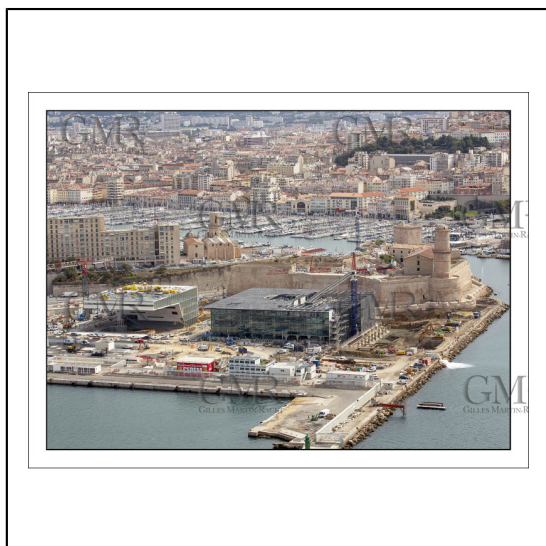
28/09/2012 - Marseille (FRA,13) - Travaux sur le Vieux Port, Construction du MUSEUM, Renovation du Fort Saint Jean, construction du Centre Régional de la Meriterranée, CEREM,
